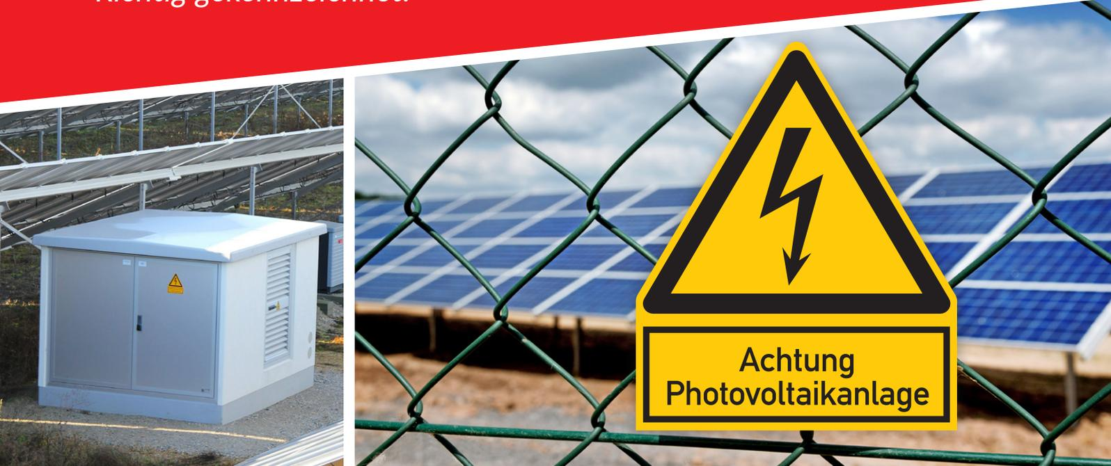
Photovoltaikanlagen müssen normgerecht gekennzeichnet werden. Das betrifft sowohl die Kennzeichnung mit Warnhinweisen zur Warnung vor gefährlicher elektrischer Spannung, als auch die Brandschutzkennzeichnung mit Hinweisen für die Feuerwehr. Große Solarfelder werden zudem meist zusätzlich mit weiteren Hinweisen zu Betretungsverboten und zur Videoüberwachung gekennzeichnet. Ist die PV-Anlage mit einem Batteriespeicher verbunden, bestehen umfangreiche Kennzeichnungspflichten gemäß VDE-AR-E 2510-2.
